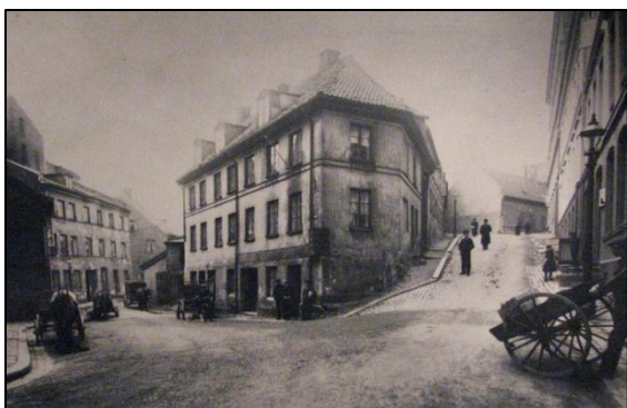
Hjørnet Bakkegaten-Strandgaten i Pipervika.
