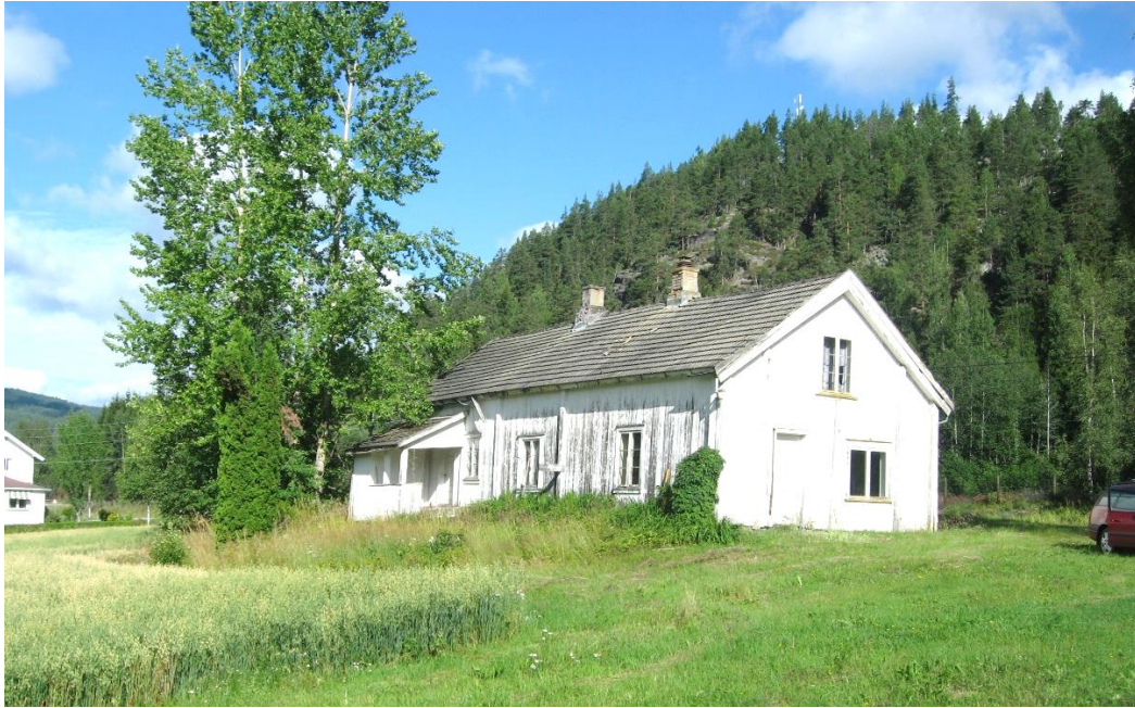
Våningshuset på Nordre Bårnås, bygd omkring 1794 (Granum 1990:392). Foto: Else Marie Abelgård.
