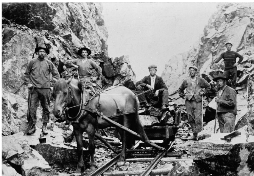
Skjæringa ved Bårnås ved leggingen av Bergensbanen i 1908. På vogna sitter Paul Modalen (1895-1983), på Nordre Bårnås fra 1928. Fotograf ukjent/Buskerud Fylkesfotoarkiv.
